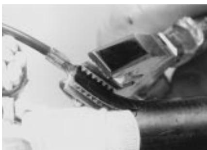
4 Используя плоскогубцы, подключите зажимы провода для восстановления экрана к металлическим оболочкам (экранам) кабелей.
