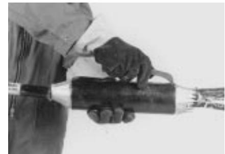
9 Повторите те же операции с другой стороны. Сделайте продольный надрез на муфте и каркасе и снимите их.
