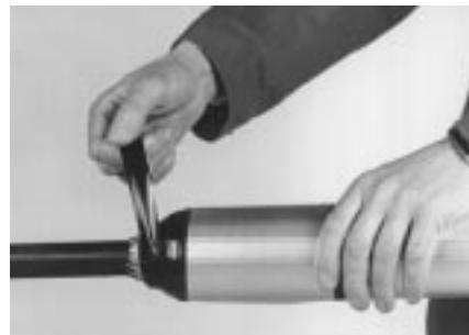
8 Обмотайте липкой лентой зубчатые края прокладки-каркаса, начиная с цилиндрической части каркаса (10 мм) и далее по конусу к оболочке кабеля с 50% перекрытием. (Используйте термостойкую ленту).
