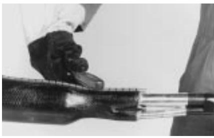
22 Прижмите застежку тупым инструментом, чтобы она повторяла форму конуса муфты. Примечание для разветвительных соединений: Сожмите ответвляемые кабели пластмассовым паяком из комплекта ВОКТ. Повторите операции 20 и 21, начиная с центра и перемещая пламя к другому концу муфты. Подождите 15 минут, чтобы муфта остыла, перед тем как дальше работать с кабелем.
