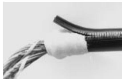
3 Подложите хлопчатобумажную или поливинилхлоридную ленту под полоску оболочки кабеля (см. рисунок). Соедините проводники кабеля, следуя обычной методике сращивания.
