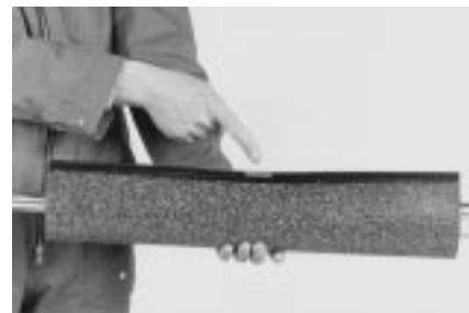
15 Оберните термоусаживаемую манжету вокруг сростка. Установите стопорный хомут (если такой имеется) поверх направляющих пластин (рельсов) и сожмите его в центре муфты.
