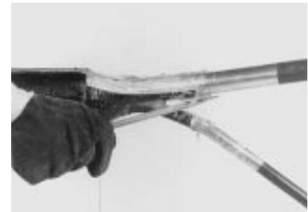
6 Пока клей горячий, разделите кабели соответствующим инструментом (отверткой), чтобы легче было вставлять разветвительный зажим при монтаже новой муфты.
