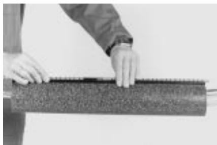
17 Надвиньте гибкие застежки на направляющие пластины (рельсы) и продвиньте их до стыковки над стопорным хомутом. Отцентрируйте муфту на сростке так, чтобы края ее совпадали с синими линиями на алюминиевой фольге.
