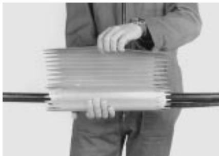
7 Перед установкой сверните прокладку-каркас, придав ей цилиндрическую форму. Плотно обмотайте место сростка прокладкой-каркасом и закрепите края липкой лентой.
